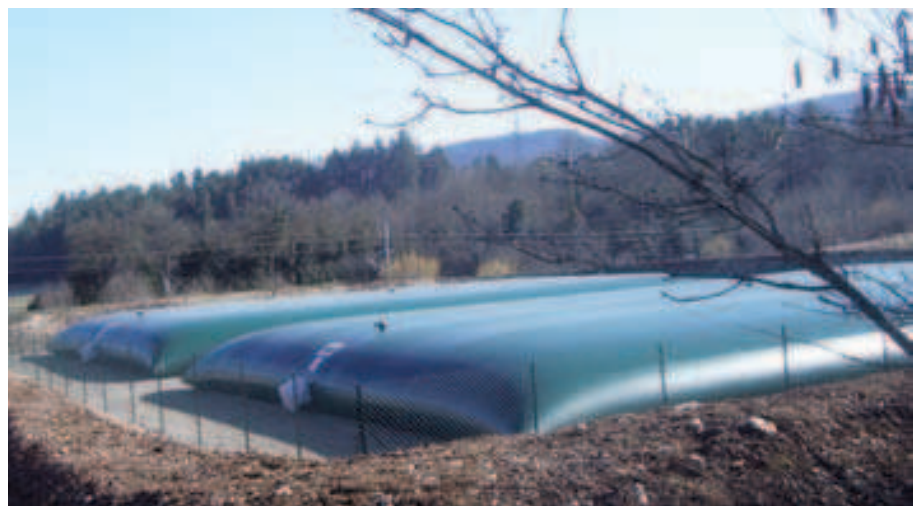
Installation von Brandschutzmaßnahmen mit Eog-INC14
