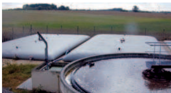
2 x 150 m³ Klärschlamm
