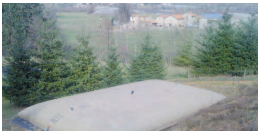
Stockage de 300 m³ de purins
