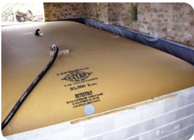
Stockage de 95m 3 de solution azotée avec rétention
