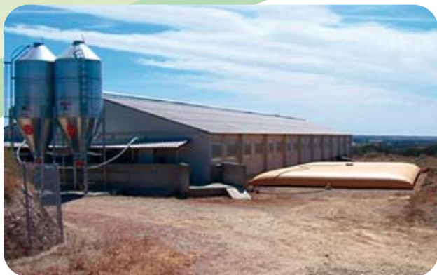
Stockage d'eau pour alimentation d'un poulailler 200 m 3
