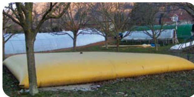
Stockage d'eau pour irrigation 50m 3
