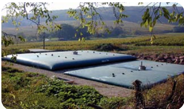
Traitement d'effluents viticoles 100 et 150 m3
