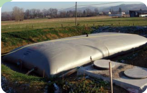
Stockage de lisiers 100m3 avec préfiltre
